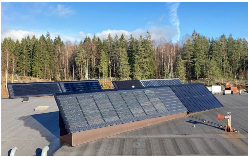
Figur 1 RISE testbädd för prestandaprovning av mindre solexsystem togs i bruk under 2020.
